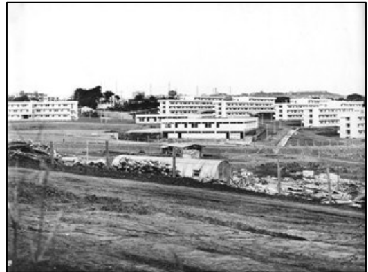
Le Village Méditerranéen en cours de construction
