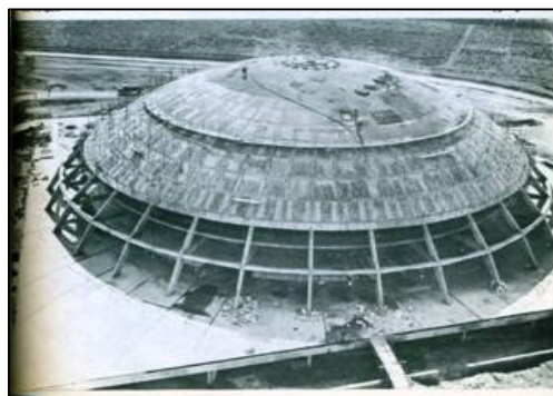
Le Palais des Sports en chantier
