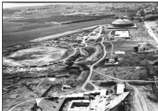
Travaux de construction des installations sportives
